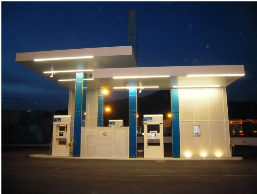
Figura 29: impianto di distribuzione idrogeno presso il casello di Bolzano Sud. Fonte: Bottoli, 2018.
